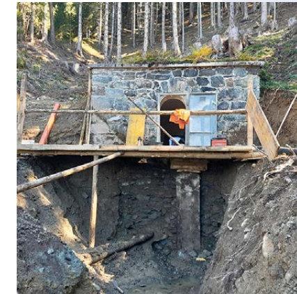
Sanierung Quellsammelstube Münzbodenquelle
