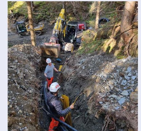
Bau der Quellableitung
