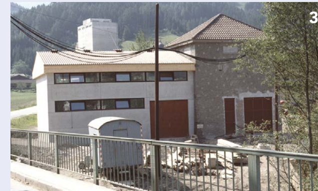
1: Eröffnungsfeier am 1. Oktober 1983 2: Bau der Wasserfassung Hasensäge/Müllau 1982 3: Neubau Krafthaus an die bestehende Schaltanlage 1983
